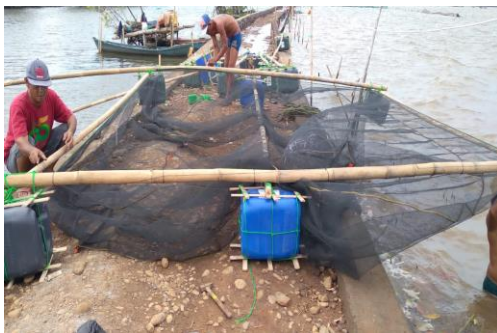
Gambar 3. Pembuatan floating cage
