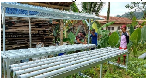
Gambar 4. Pemasangan instalasi hidroponik
