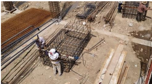
Gambar 4. Tempat Fabrikasi tulangan
